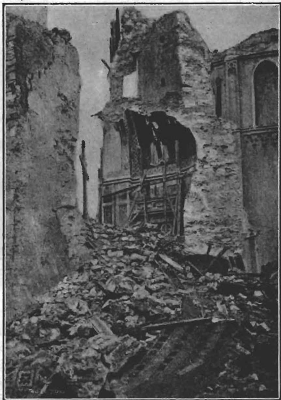
FIG. — 10 a . — Duomo di Messina: veduta dell' interno.
