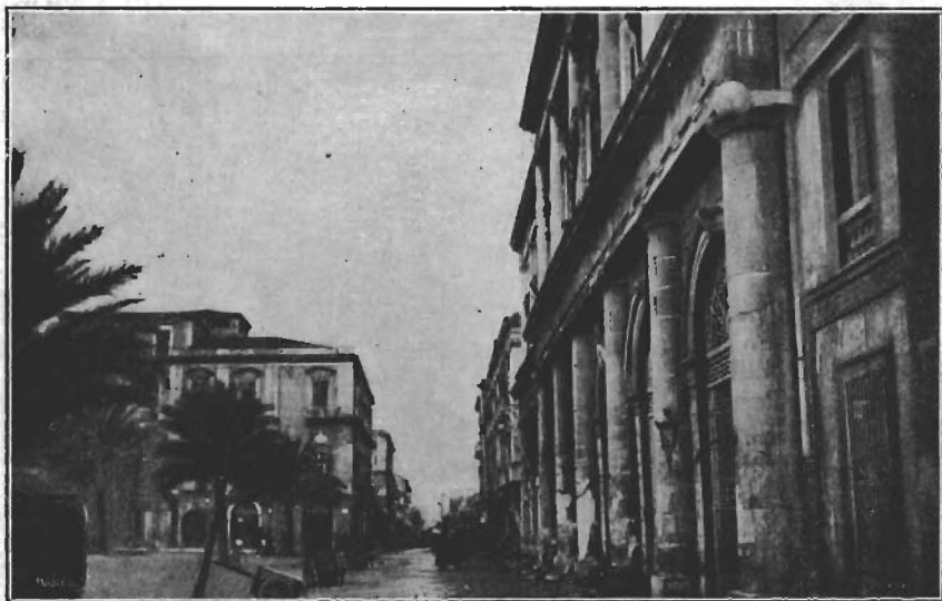
FIG. 12 a . — Il Municipio (facciata verso la piazza).
