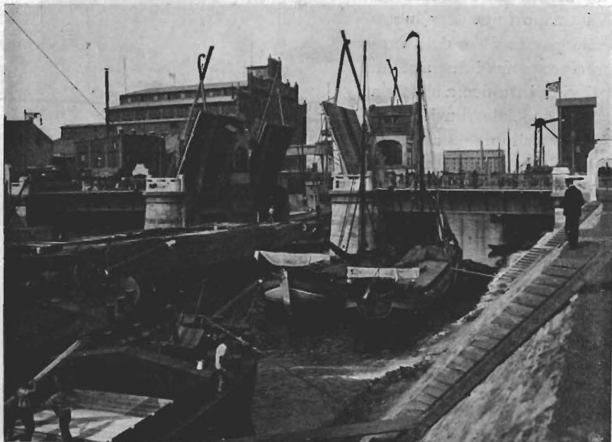
FIG. 16 a . — Il Reno a Duisburg. Un punto del bacino con ponte apribile.
