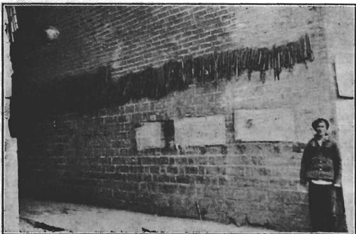
FIG. 4ª. — Interno della porta del Nord a Junnansen con le pipe esposte.
