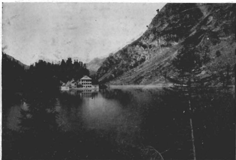
Lago di Co' di Lago - Vista della diga a monte.
