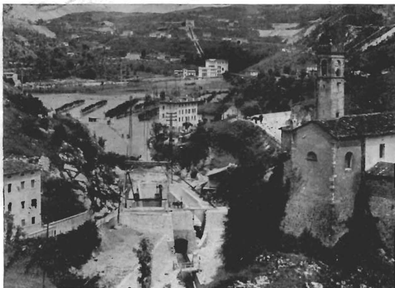
Lago-serbatoio del Restello visto da sud. In primo piano lo sbarramento e le opere di presa per la centrale di S. Floriano.
