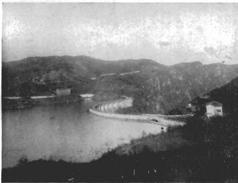
Lago-servatoio delle Scalere.
