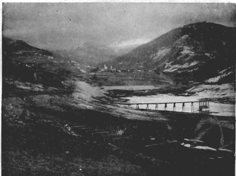
Lago-serbatoio delle Piazze - Stato dei lavori nel marzo 1924.
