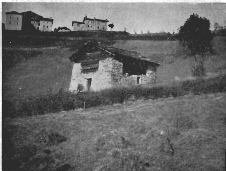
Fig. 3. — Tipo di Masón con stalla a pian terreno, in muratura, e fenile al primo piano, dalle pareti parzialmente di tronchi. In alto, le più elevate abitazioni permanenti di Caspoggio, con qualche finestra incorniciata di calce.
