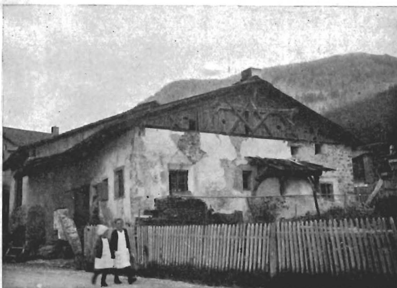
Fig. 2 - Casa tipica di Resia. Differisce dalla precedente perchè la scala esterna è riparata da una appendice del tetto principale. Si noti il forno, riparato da un tettuccio di legno.
