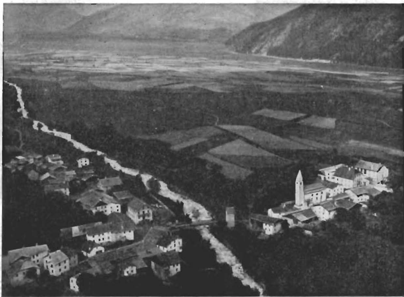
Fig. 5 - Veduta della parte inferiore della Mutta di Malles, occupata da appezzamenti coltivati e da prati da fieno. L'Adige respinto verso l'unghia della conoide. Il paese di Clusio, centro di ponte.
