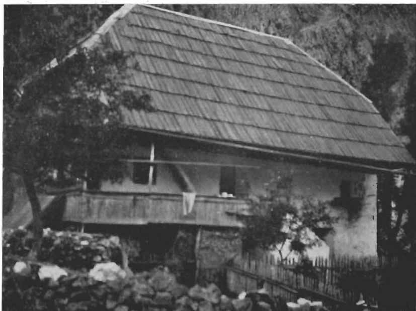
Tipica abitazione slavo-alpina. Sotto al ballatoio la scorta di legna. Si nota la scala che dà accesso al sottotetto. Davanti alla casa, accuratamente recintato, il piccolo orto.
