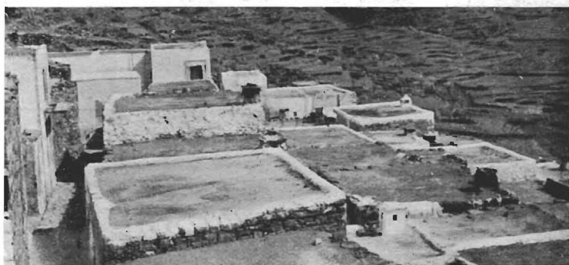
Fig. 14. — Una parte delle case di Spoa, col tetto di terra battuta.
