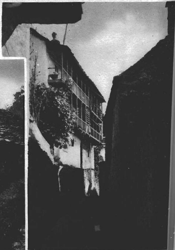
Casa di Unchio, in cui la loggia è parte costruita in legname e parte in tondini di ferro (agosto 1914). (Foto Pullè).
