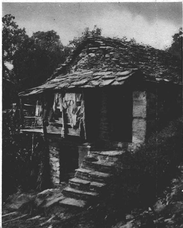
Casa di Unchio, in cui la loggia è parte costruita in legname e parte in tondini di ferro (agosto 1914). (Foto Pullè).
