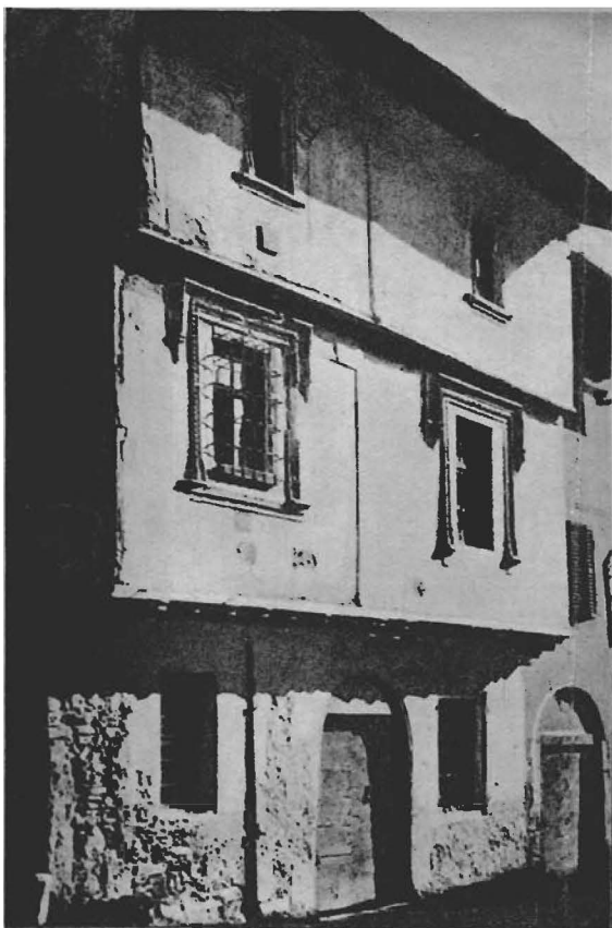
Nella facciata esterna le travature sporgenti si ripetono ad ogni piano ed i muri si susseguono con sporgenze successive.
