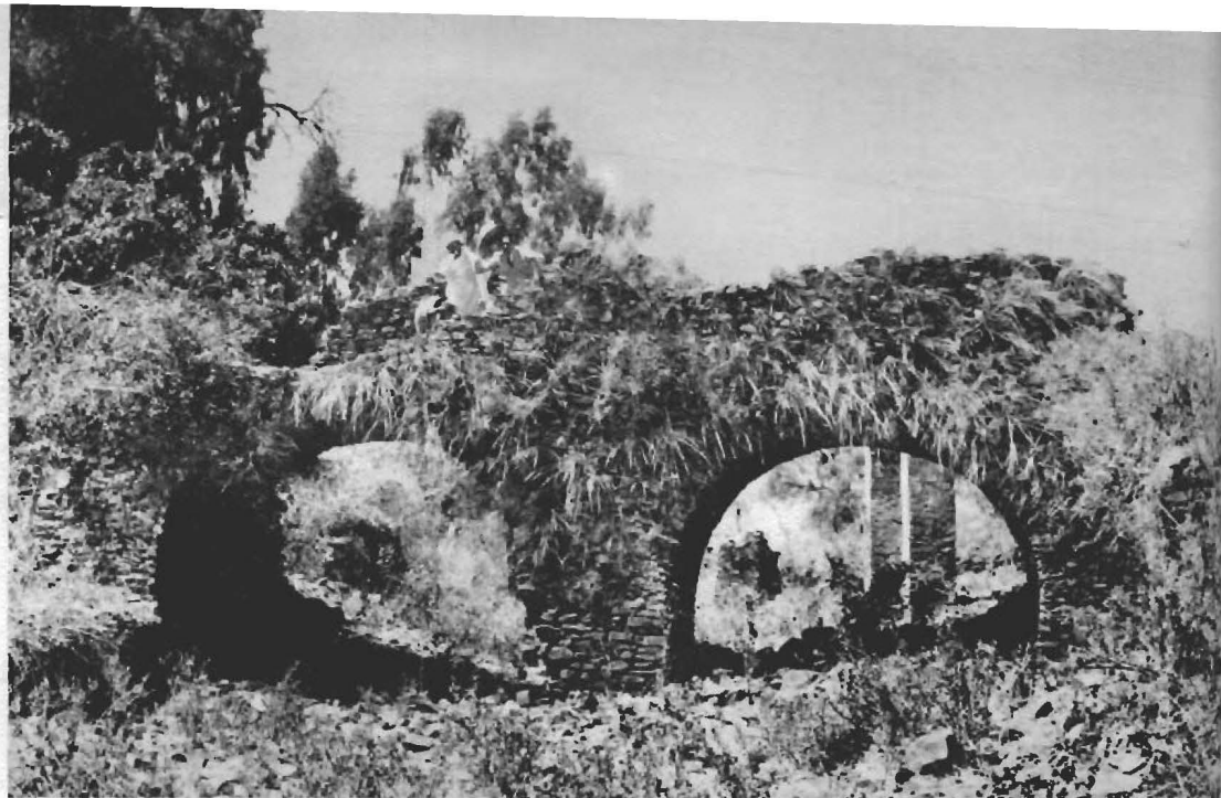
Ponte sul fossato dei Castelli di Gondar.
