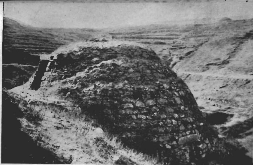
Grotta Monaci - Niviera del tipo a cupola a curva parabolica ad anelli, rustica
