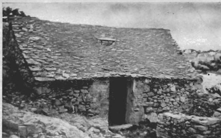
Casupola ( potlenšica ) a S. Giovanni costruita con pietre senza calcina. Il tetto è di lastre di pietra.
