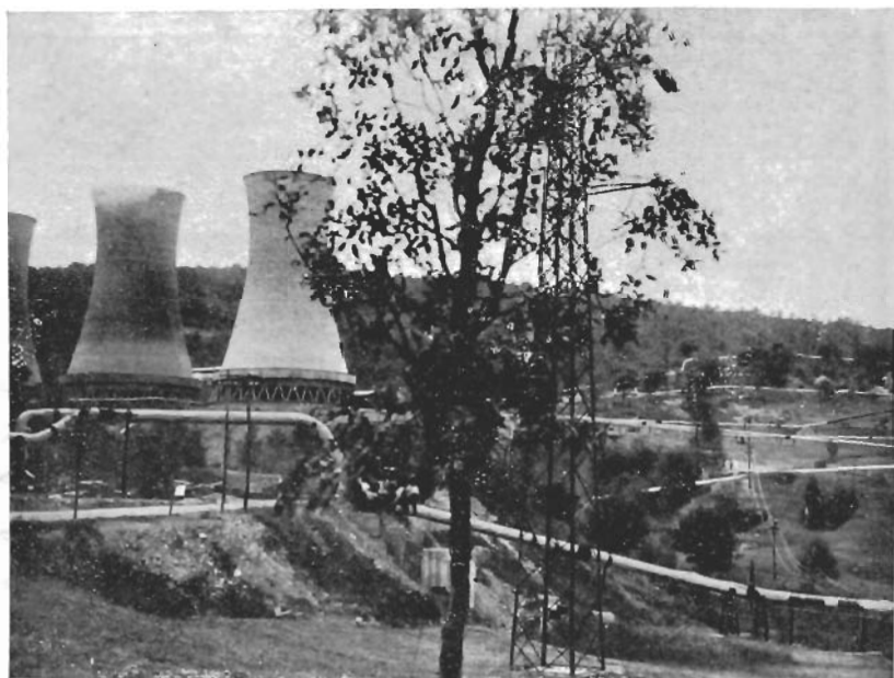
LARDERELLO : tubazioni e torri di refrigerazione.
