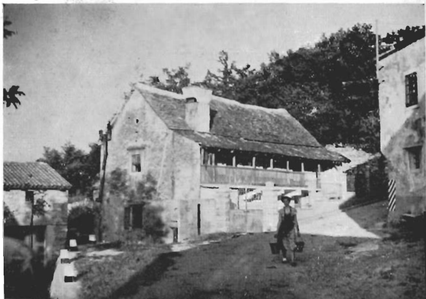
VECCHIA CASA CON TETTO COPERTO DI LASTRE DI CALCARE a Zolla, in comune di Monrupino.
