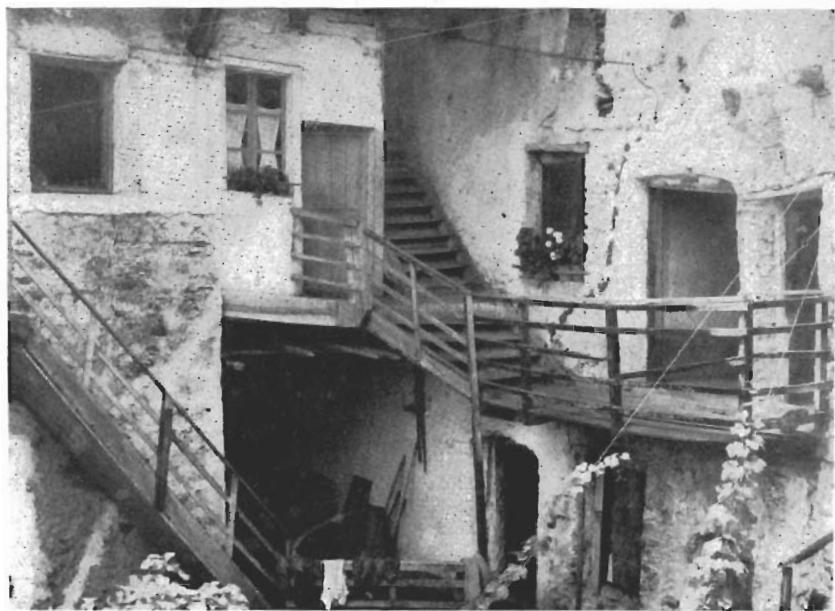
SELVA: FACCIATE SULLA CORTE DEI MOSCHENI, una delle più antiche della zona.
