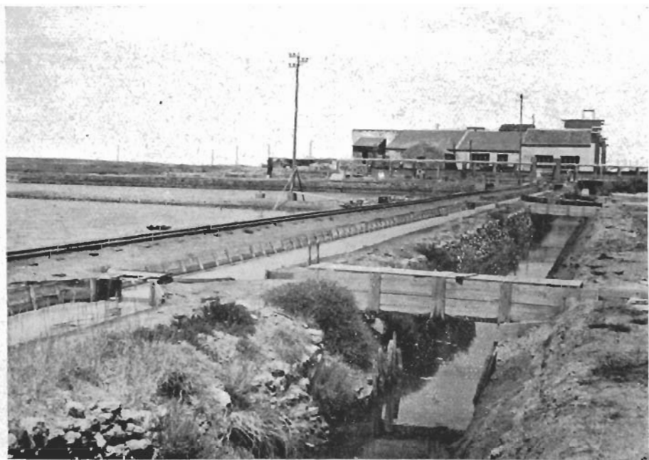
SALINA DI TARQUINIA: PARTICOLARE DI CANALI A DIVERSO LIVELLO. In secondo piano gli edifici per l'idrovora e per la solificazione del sale. (fot. O. Baldacci)
