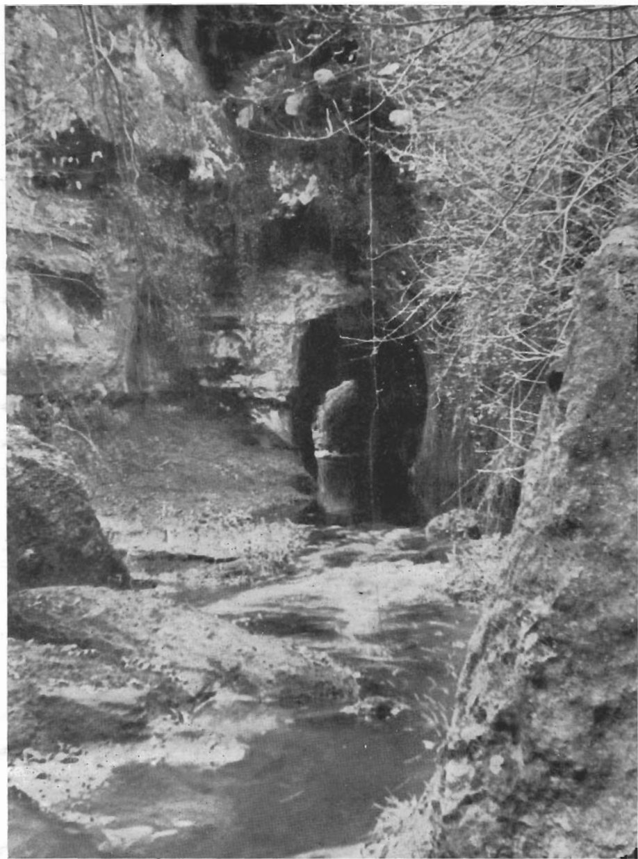
Fig. 2. - IMBOCCATURA, A VALLE, DEL « PONTE SODO ».
