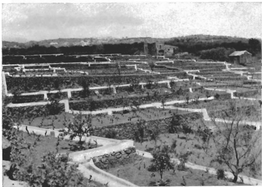
Rete di canali in muratura ( saia ) per l'irrigazione di agrumeti, presso Nicolosi.
