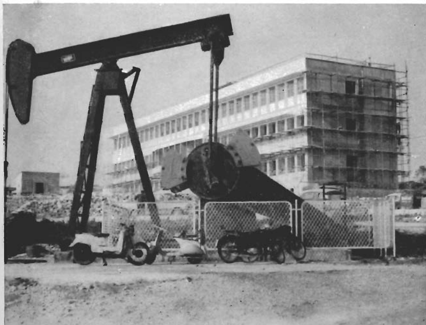
Un pozzo petrolifero presso l'edificio in costruzione per la Gulf Italia Co. , a Ragusa. ( fol. R. Ronchi )
