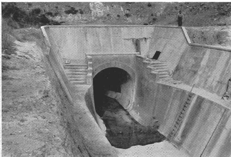
LO SBOCCO DELLA GALLERIA DI DERIVAZIONE NEL RIO S. ANTONIO, PRESSO ARIXI (LUNGH. km 9,9).
