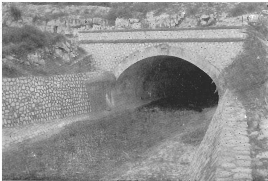
LO SBOCCO DEL CANALE PEDEMONTANO A VALLE DELLA VIA APPIA.
