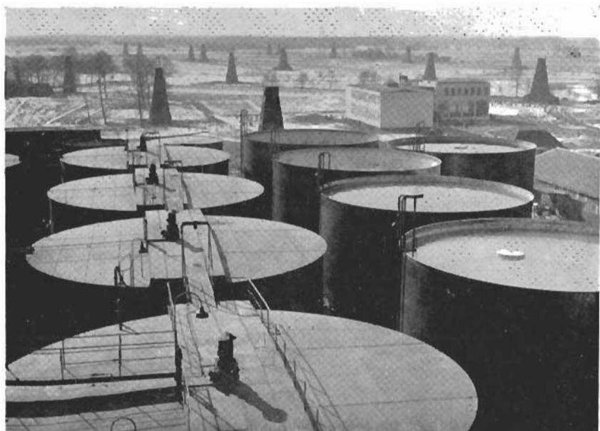
VEDUTA PARZIALE DEI SERBATOI PER LA RACCOLTA DELLA SALAMOIA E, NELLO SFONDO, DELLA PARTE DEL CAMPO DI ESTRAZIONE DEL SALGEMMA PIU' VICINA AL COMPLESSO INDUSTRIALE DI HENGEL.
