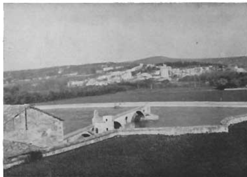
IL RODANO DAL ROCHER DES DOMS DI AVIGNONE.
