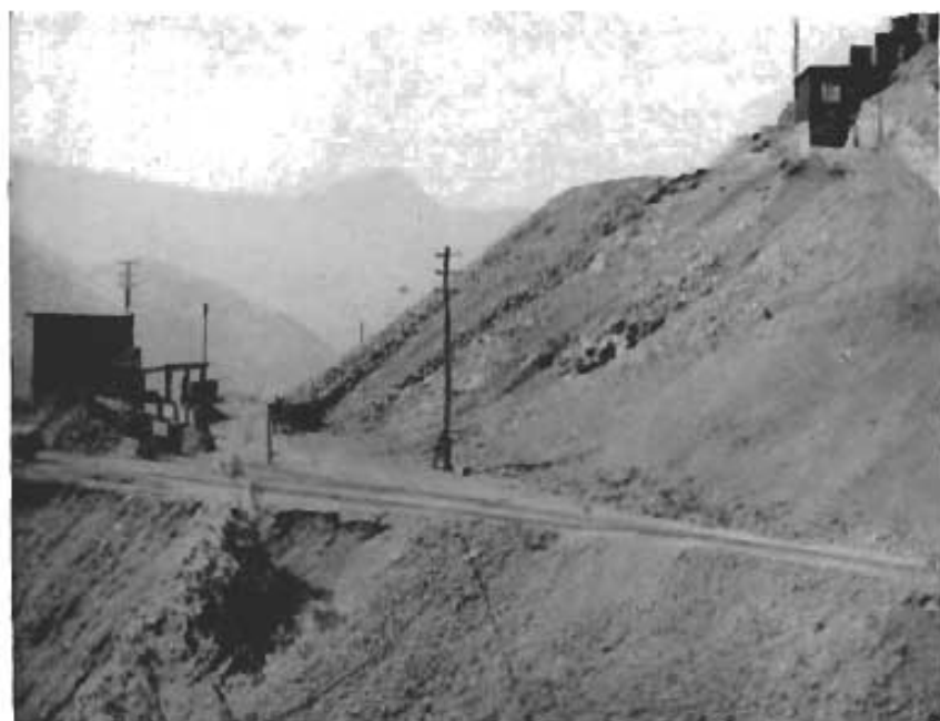
STAZIONE DI PARTENZA DEL MINERALE DI MANGANESE DELLA MINIERA DI GAMBATESA. IN VAL GRAVEGLIA
