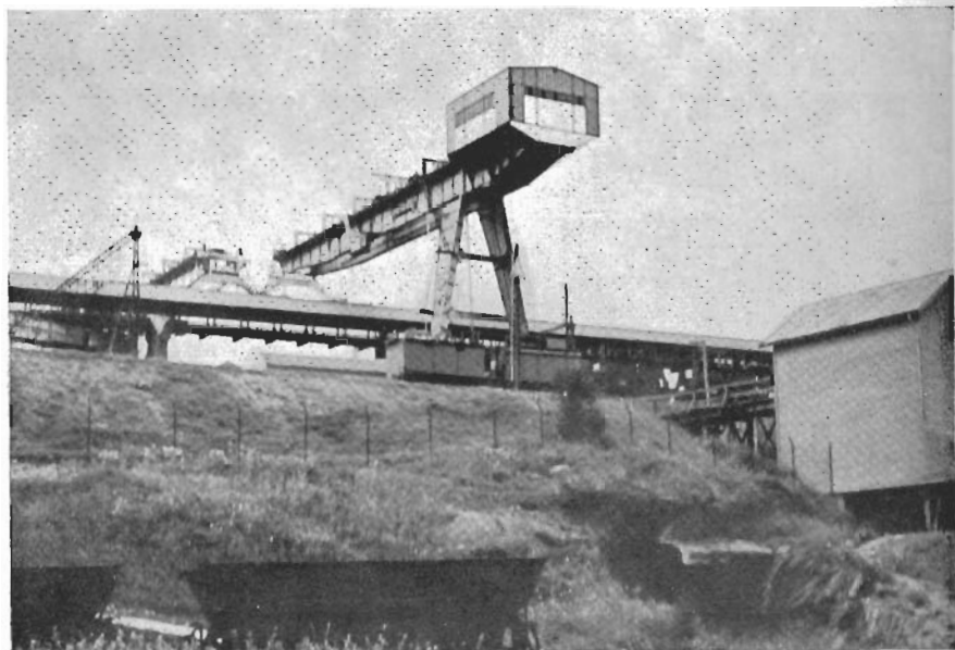
Narvik. — Installazioni per il carico del minerale di ferro proveniente da Kiruna . (fot. C. Della Valle)
