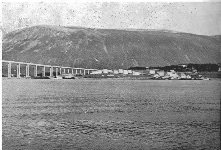
Tromsdal e l'inizio, sul continente, del ponte che unisce l'isola di Tromsø alla terraferma.
