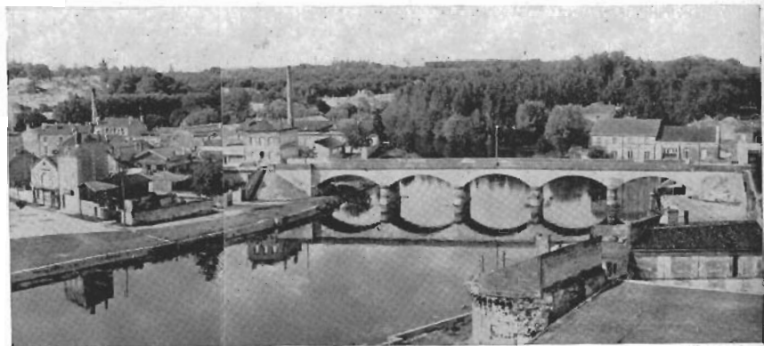
Cognac: il ponte sulla Charente e, a sinistra, parte del faubourg Saint-Jacques. ( fol. M. Pinna )
