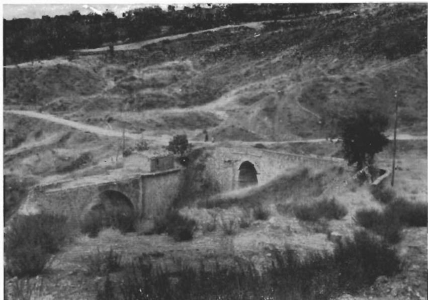
UNA ZONA FRANOSA LUNGO LA STRADA ROCCA IMPERIALE-CANNA. Due ponti sono stati messi fuori uso dal cedimento del terreno.
