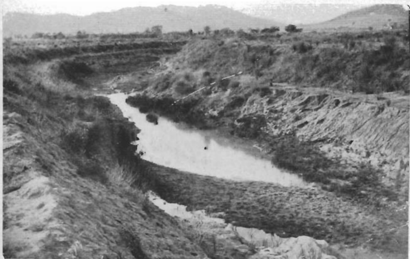
UN TRATTO DEL PANTANO PRIMA DELLA BONIFICA.
