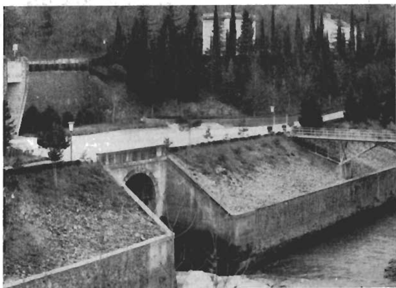
LO SBOCCO ESTERNO DELLA GALLERIA CHE PORTA ALLA CENTRALE DI SAN GIACOMO.
