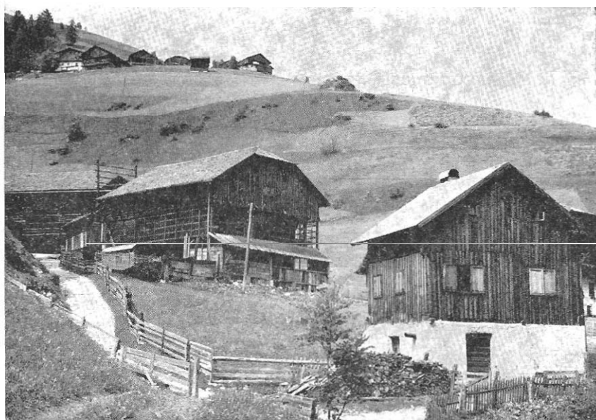
Fig. 2 — Longiarù. Casa con imbasamento di muratura e il resto di legno. (Si noti il maggiore sviluppo della « majun », circondata dal « parincing ». Lo steccato ad elementi orizzontali, « si da albügn », orla la strada, mentre, accanto all'abitazione, l'orticello è protetto dallo steccato ad elementi più fitti e verticali, « speltes »).
