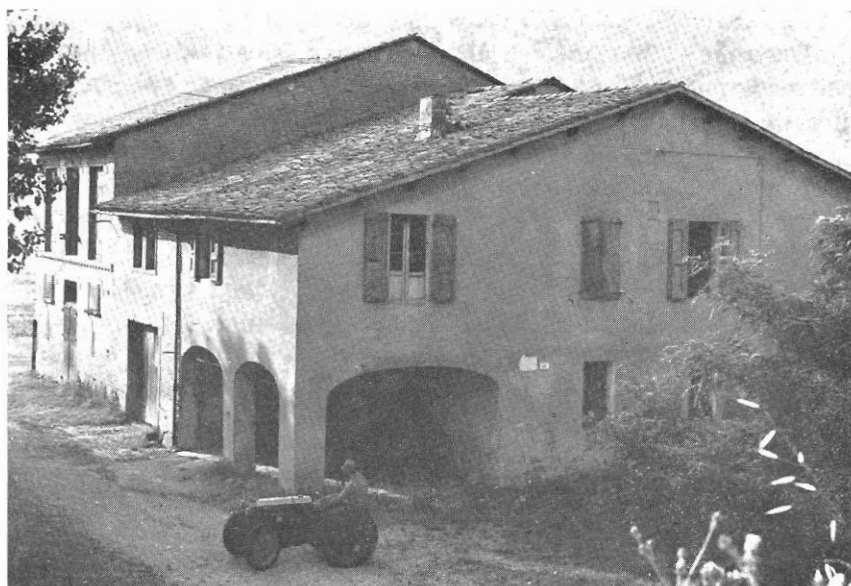
Fig. 3 — Casa colonica nel podere di Casola di sotto, notevolmente ampliata rispetto al 1920.
