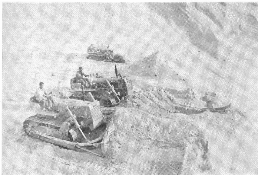
Escavazione nel giacimento a mezzo di bulldozers.
