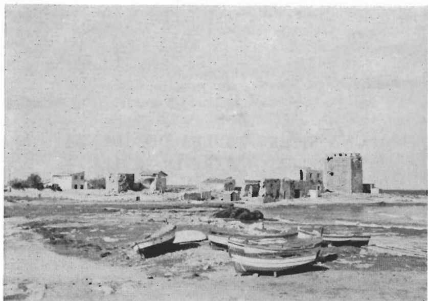
FIG. 1 — RUDERI DELL'IMPIANTO A TERRA DELLA TONNARA DELL'ORSA (PUNTA RAISI).
