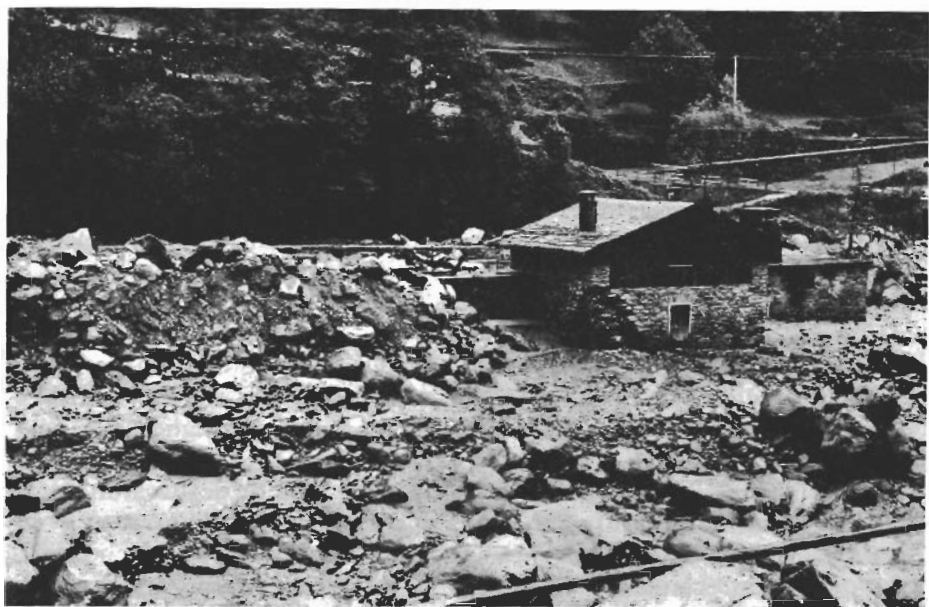
FIG. 3 — L'ALVEO DEL MALLERO A VALLE DI TORRE DI SANTA MARIA DOPO L'ALLUVIONE DEL LUGLIO 1987.
