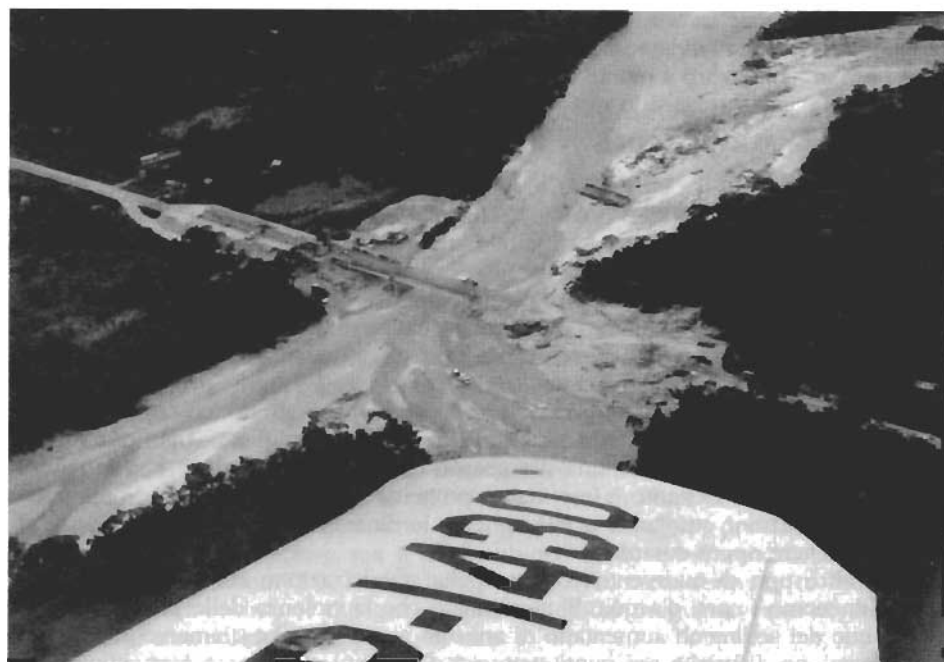
FIG. 6 - VEDUTA AEREA DEL PONTE SUL RÍO CONI.
