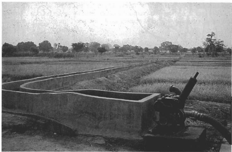
FIG. 6 – COMPENSORIO IRRIGUO DI JAHALY-PACHARR (GAMBIA): OPERE DI CANALIZZAZIONE PER LA RISICOLTURA COMPLETAMENTE CONTROLLATA.
