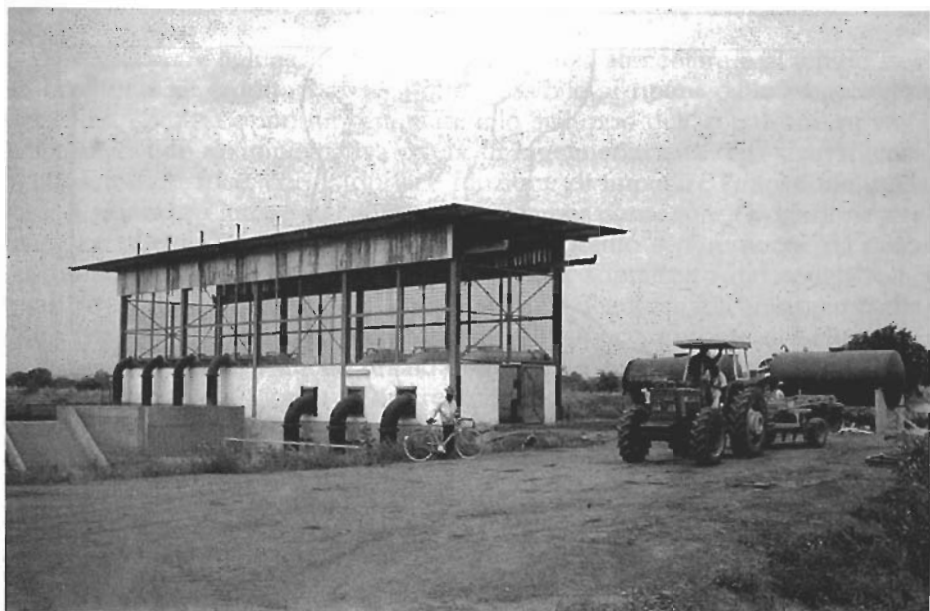
FIG. 5 – COMPENSORIO IRRIGUO DI JAHALY-PACHARR (GAMBIA): STAZIONE CENTRALE DI POMPAGGIO A WALIKUNDA.
