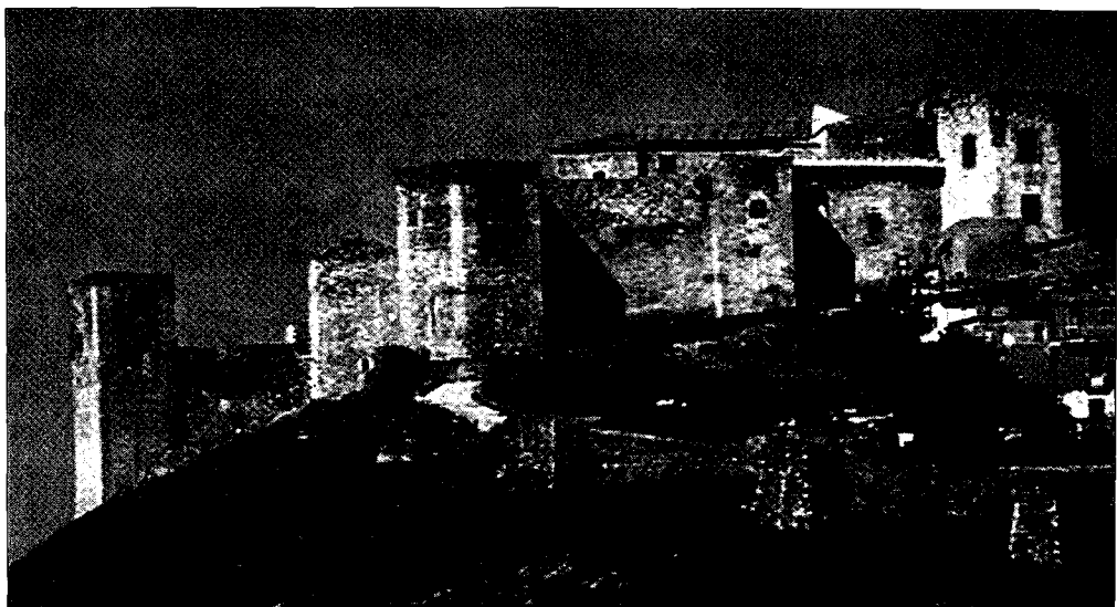
Fig. 1 – Il castello normanno-svevo di Melfi e il primo tratto della cinta muraria
