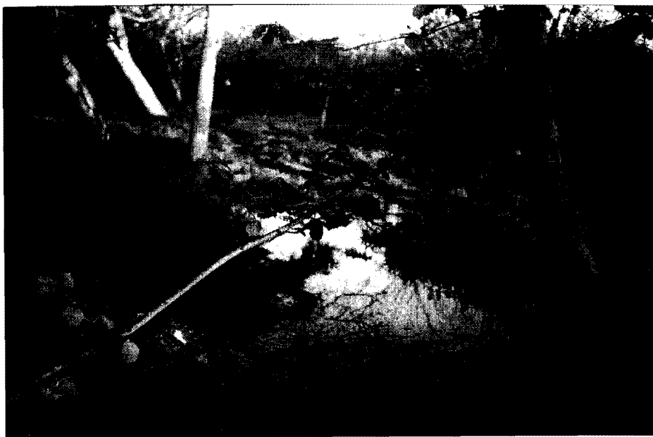
Fig. 4 – Canale Conte di Sarno. Tracimazione dell'alveo nei terreni circostanti
