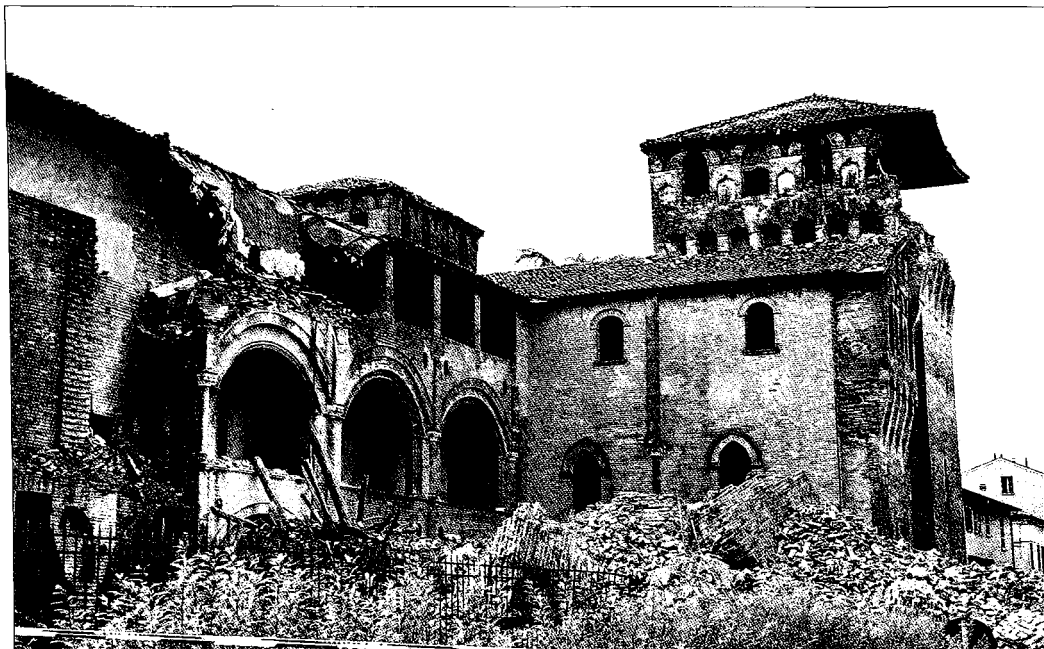
Fig. 4 – La rocca di Finale Emilia (MO) gravemente danneggiata a seguito del sisma del maggio-giugno 2012 (foto P. Guerzoni, 1° VI. 2012)
