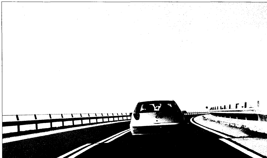
Fig. 2 – Scorrimento di due sezioni di viadotto automobilistico lungo un giunto trasversale, San Felice sul Panaro (MO) a seguito del sisma del maggio-giugno 2012 (foto P. Guerzoni, 24.V.2012)
