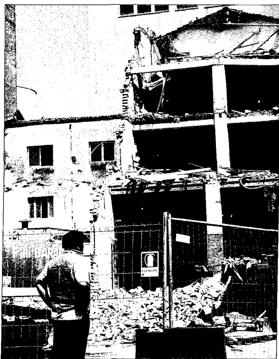
Fig. 5 – Crolli in una struttura industriale presso San Felice sul Panaro (MO) a seguito del sisma del maggio-giugno 2012 (foto P. Guerzoni, 1° VI. 2012)
