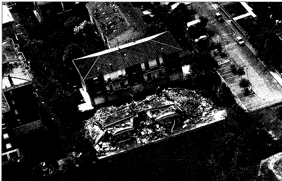
Fig. 9 – Palazzina in cemento armato a Cavezzo (MO), ridotta in un cumulo di macerie a seguito del sisma del maggio-giugno 2012 (foto dell'autore, 6.VIII.2012)
